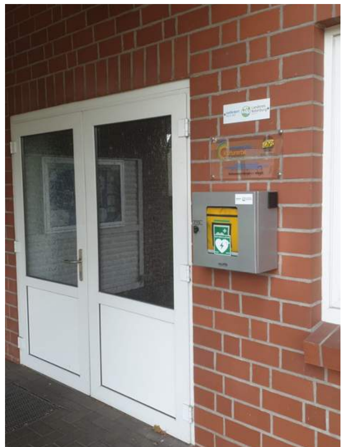
Eingang Schützenhaus Söhlingen
